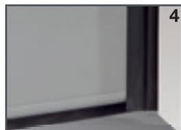
Bodenabschluss außen, in Torfarbe beschichtet
